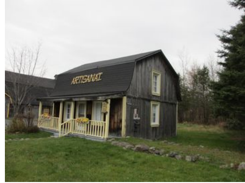
3821, 8 e Rue, Saint-Prospér.
